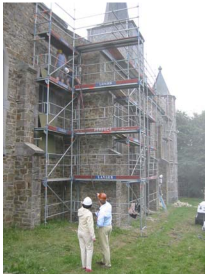
Début des travaux à l'extérieur ...
