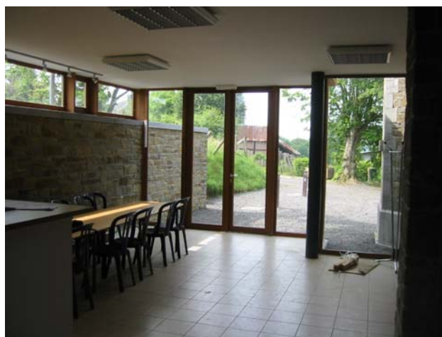
L'extension vue de l'intérieur
